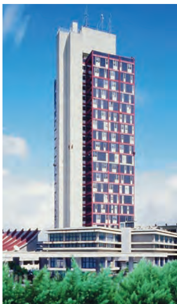
Fig. 122 - Torre con i Dipartimenti biologici.
