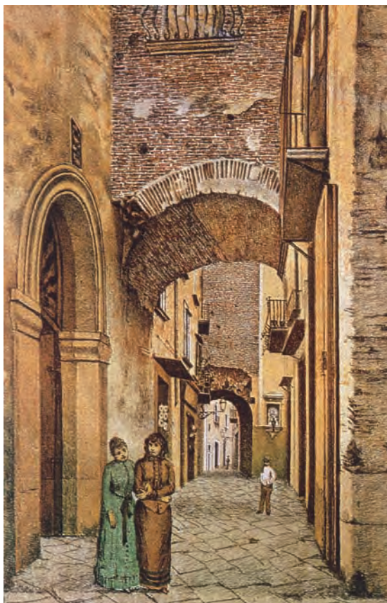
Fig. 67 - Via dell'Anticaglia, con i contrafforti del teatro romano.
